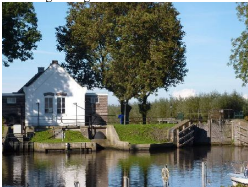
Gemaal Eemnes en rechts de sluis.
